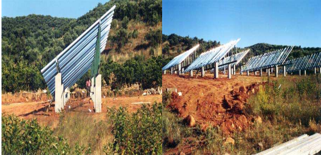
Σχήμα 2.1 : Υποδομή στήριξης φωτοβολταϊκών κυψελών
