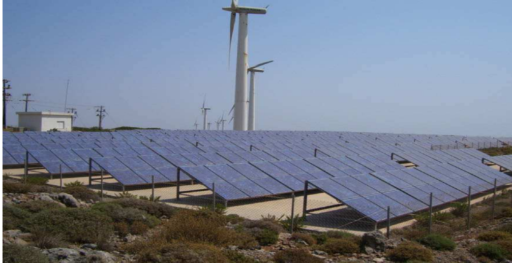
Σχήμα 3.2 : Το φ/β πάρκο με τα πάνελ να έχουν γωνία 30° και προσανατολισμό προς το Νότο
